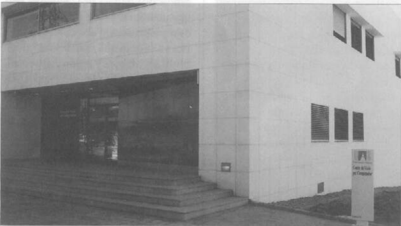
Instal·lacions del Centre de Visió per Computador.
